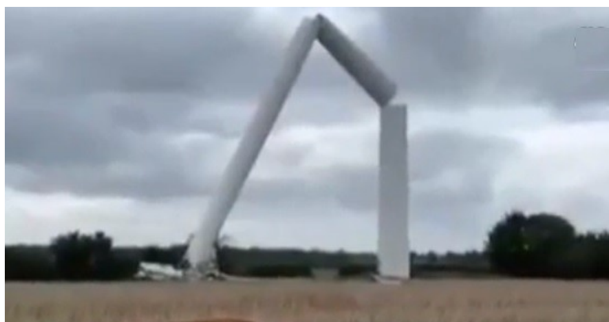
Una forte raffica di vento ha distrutto una turbina eolica alta 65 metri in un parco eolico a sud di Gnoien, nel distretto tedesco di Rostock.
